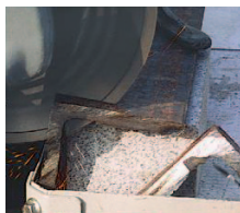
VIGAS DE HIERRO
