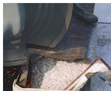
VIGAS DE HIERRO
