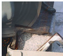
VIGAS DE HIERRO
